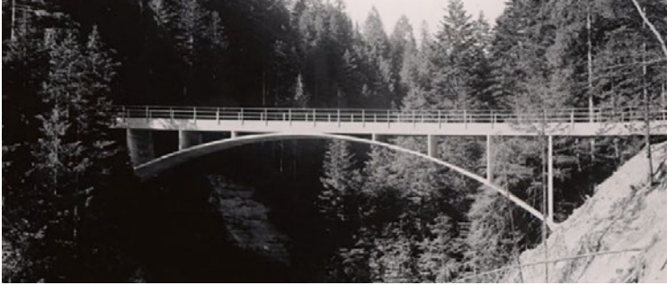
Schwandbachbrücke von Robert Maillart
