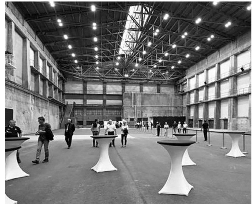
Kiesofenhalle mit Betonfachwerk
