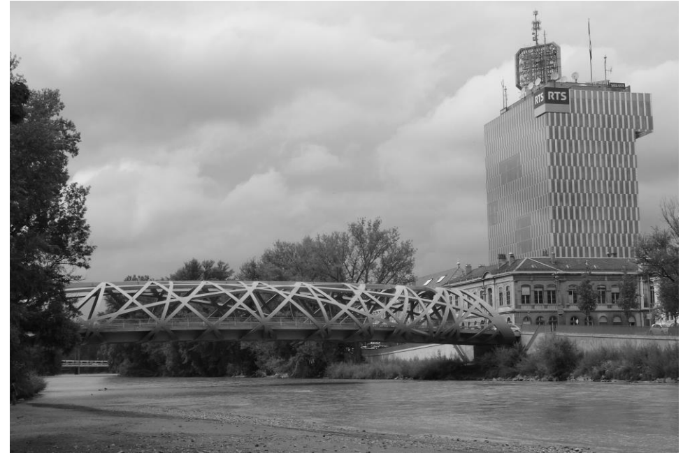
Pont Hans Wilsdorf
