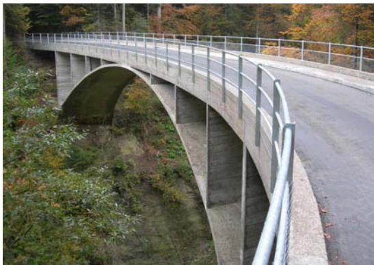
Schwandbachbrücke 1933, R. Maillart, nach der Instandsetzung 2005
