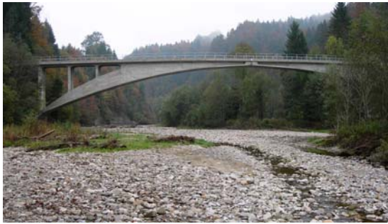
Rossgrabenbrücke 1932, R. Maillart, nach der Instandsetzung 2005
