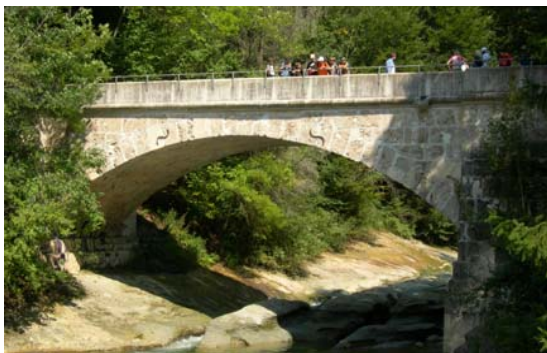
Alte Schwarzwasserbrücke 1832, nach der Restaurierung 1999
