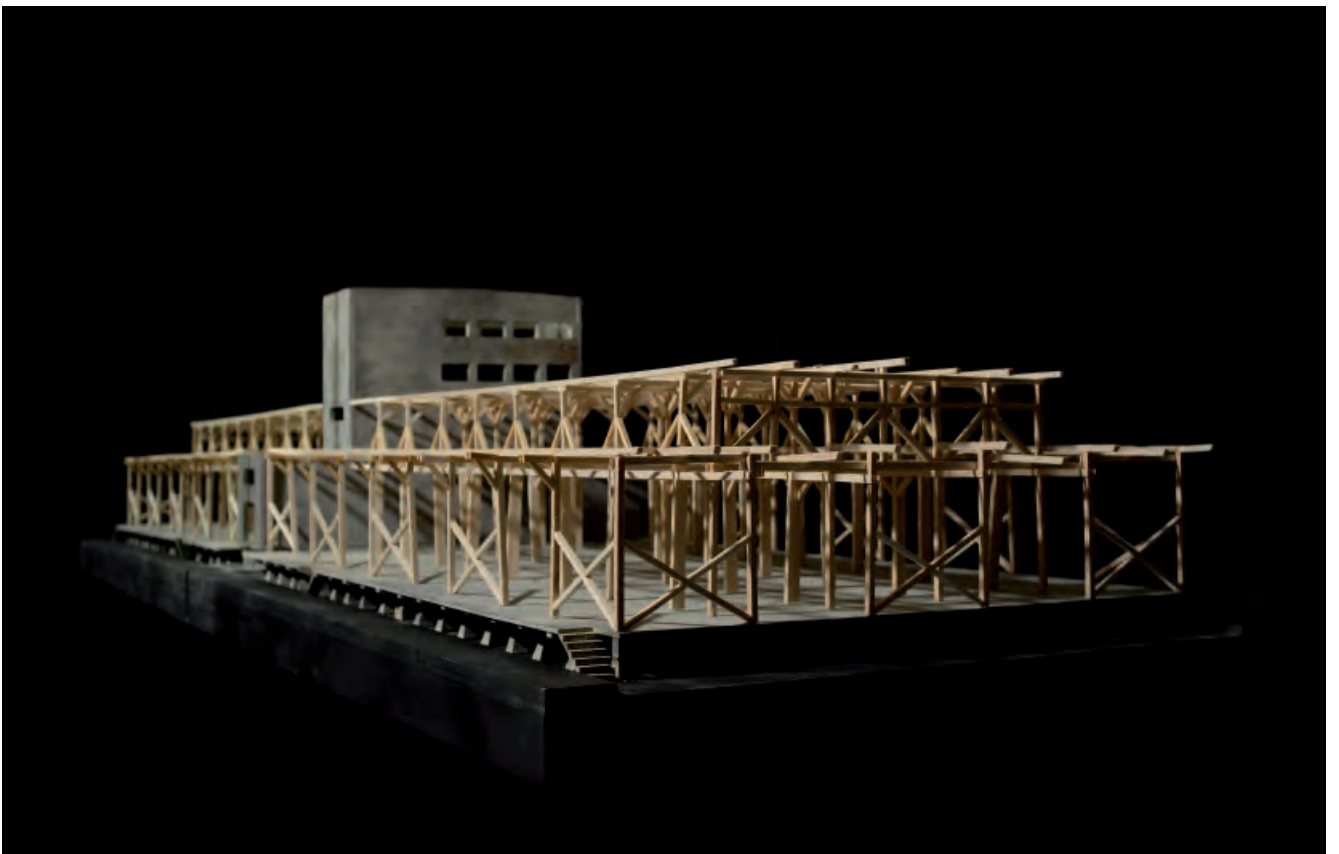
Abb. 30: Strukturmodell der Wyrshallen, Masstab 1:50, Studio Burkhalter-Sumi (AAM).
