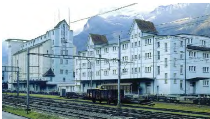
Abb. 8: Proviantlager (Sacklager) und Silogebäude.
