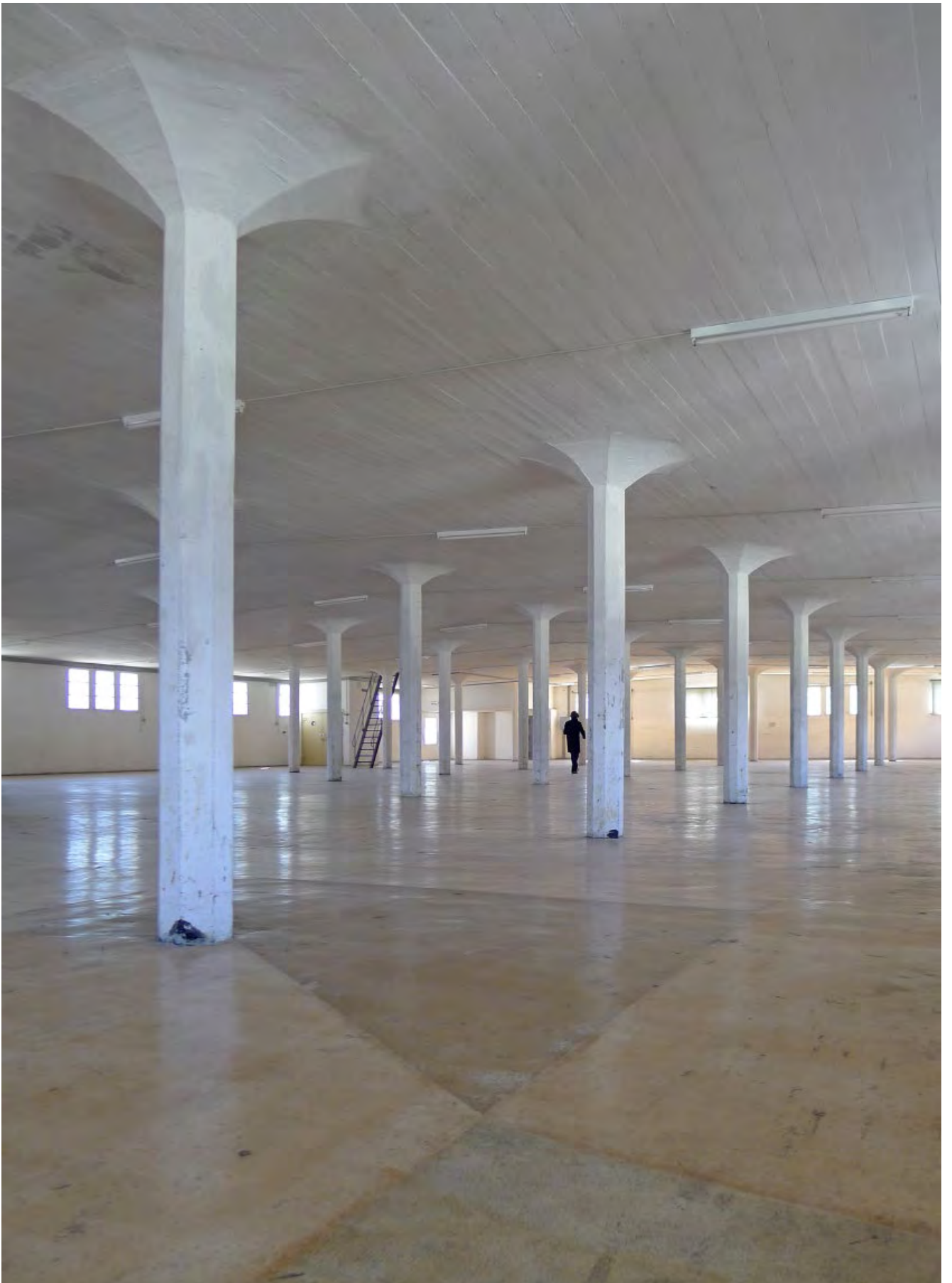
Abb. 9: 3. Obergeschoss des Sacklagers von Robert Maillart; Wände und Stützen weiss gekalkt, Holzzementboden (Aufnahme 2014).
