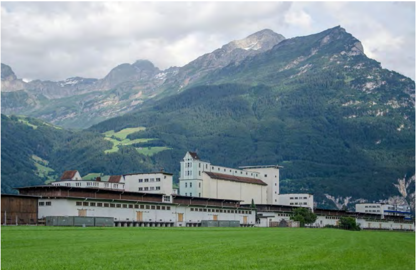
Abb. 14: Eyschachen Areal Ist-Zustand, im Vordergrund die drei Flachlagerhallen.
