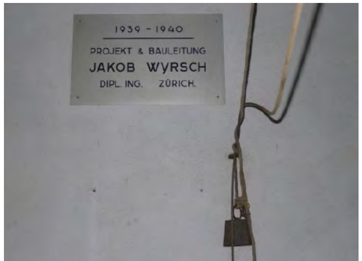
Abb. 28: Plakette im Eingangsbereich einer Flachlagerhalle.
