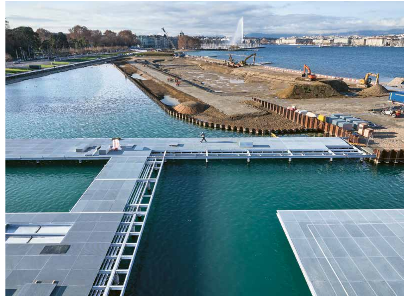
1_Aufschüttung des Strands und der Hafenplattform. Remblayage de la plage et plateforme du port. Rinterro della spiaggia e piattaforma del porto.
