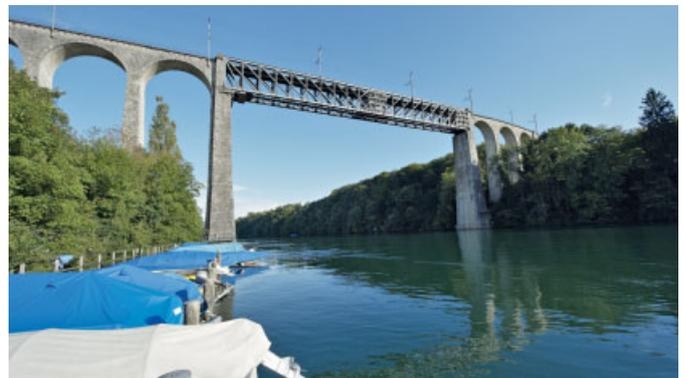
Bild 3. Stahlkonstruktion der Brücke Eglisau mit den im zentralen und rechten Bereich montierten Baugerüsten für die Sensorinstallation
