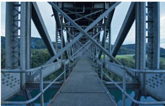
Bild 2. Inspektionsgang auf der unteren Ebene des Stahlfachwerkes
