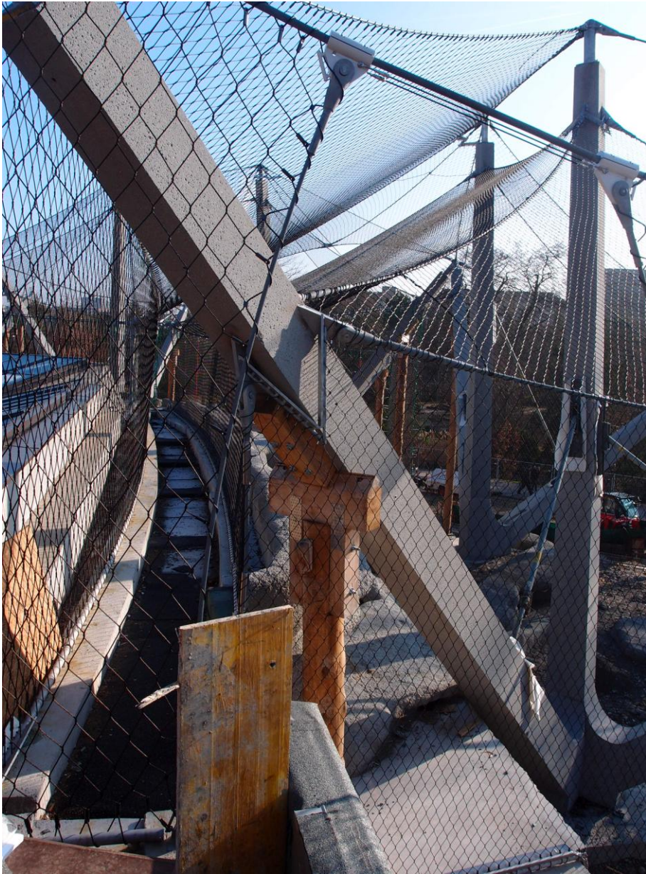
Zoo Basel, Montage der Netträume Frühjahr 2012
