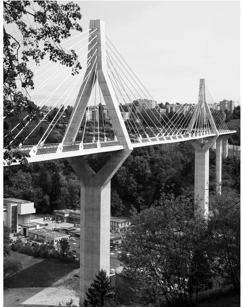
Pont de la Poya
