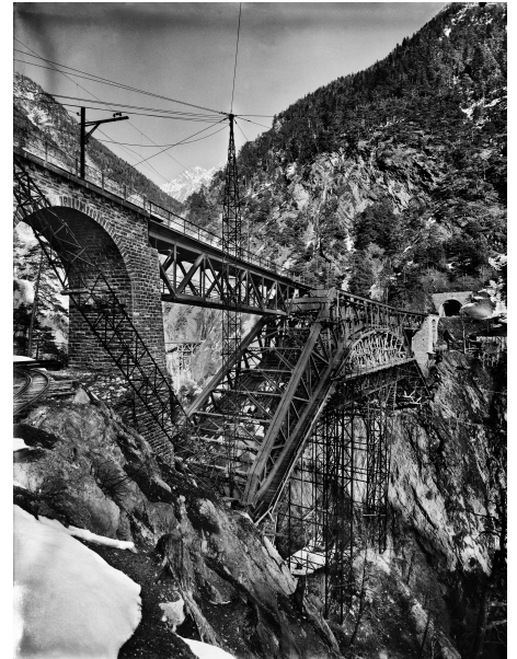
Bietschtalbrücke 1913: noch einspurig ausgebaut. Erst 1986 erfolgte der Doppelspurausbau. (Eidgenössisches Archiv für Denkmalpflege)
