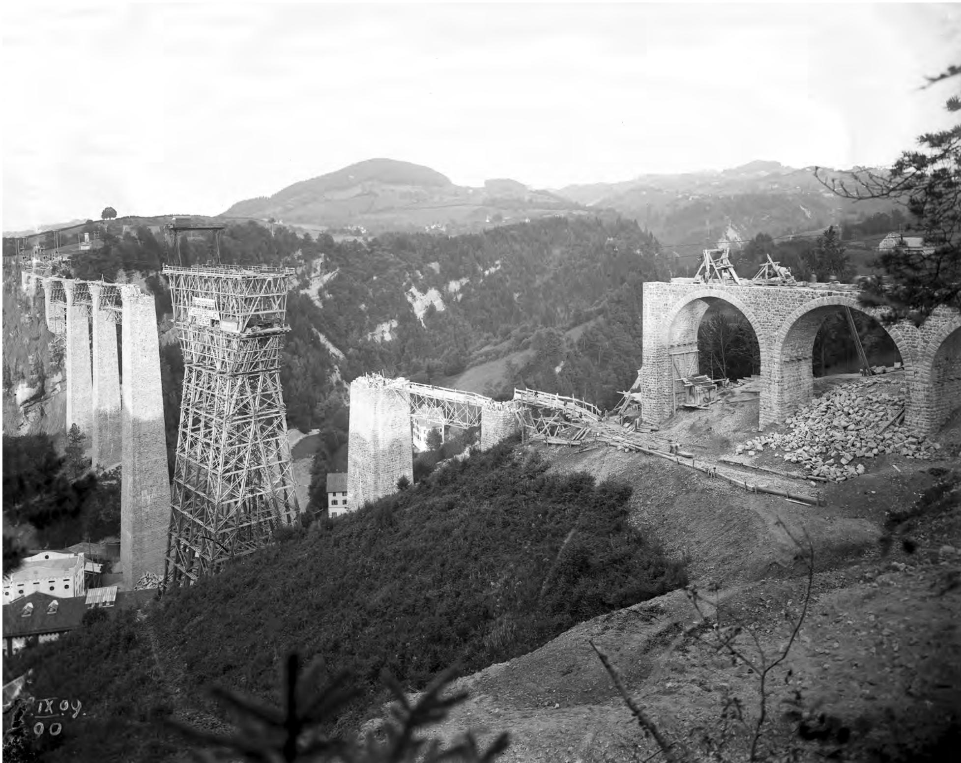
Der erste Teil des Stahlgerüsts steht bereits auf dem von Richard Coray gebauten Gerüstturm im Sittertobel.
