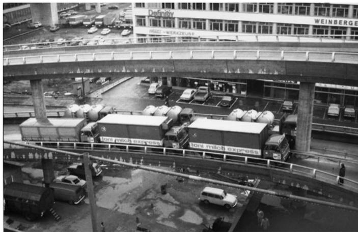
Nachdem die Rampen erstellt waren, führte die EMPA am 21. Januar 1975 Belastungsversuche auf den verschiedenen Brückenteilen durch.
