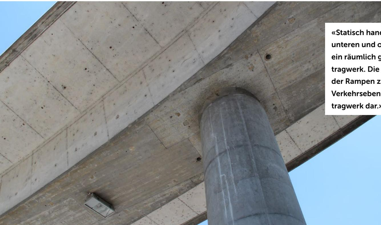
«Statisch handelt es sich bei der unteren und oberen Rampe um ein räumlich gekrümmtes Stabtragwerk. Die Übergangsbereiche der Rampen zu der mittleren Verkehrsebene stellen ein Flächen-
