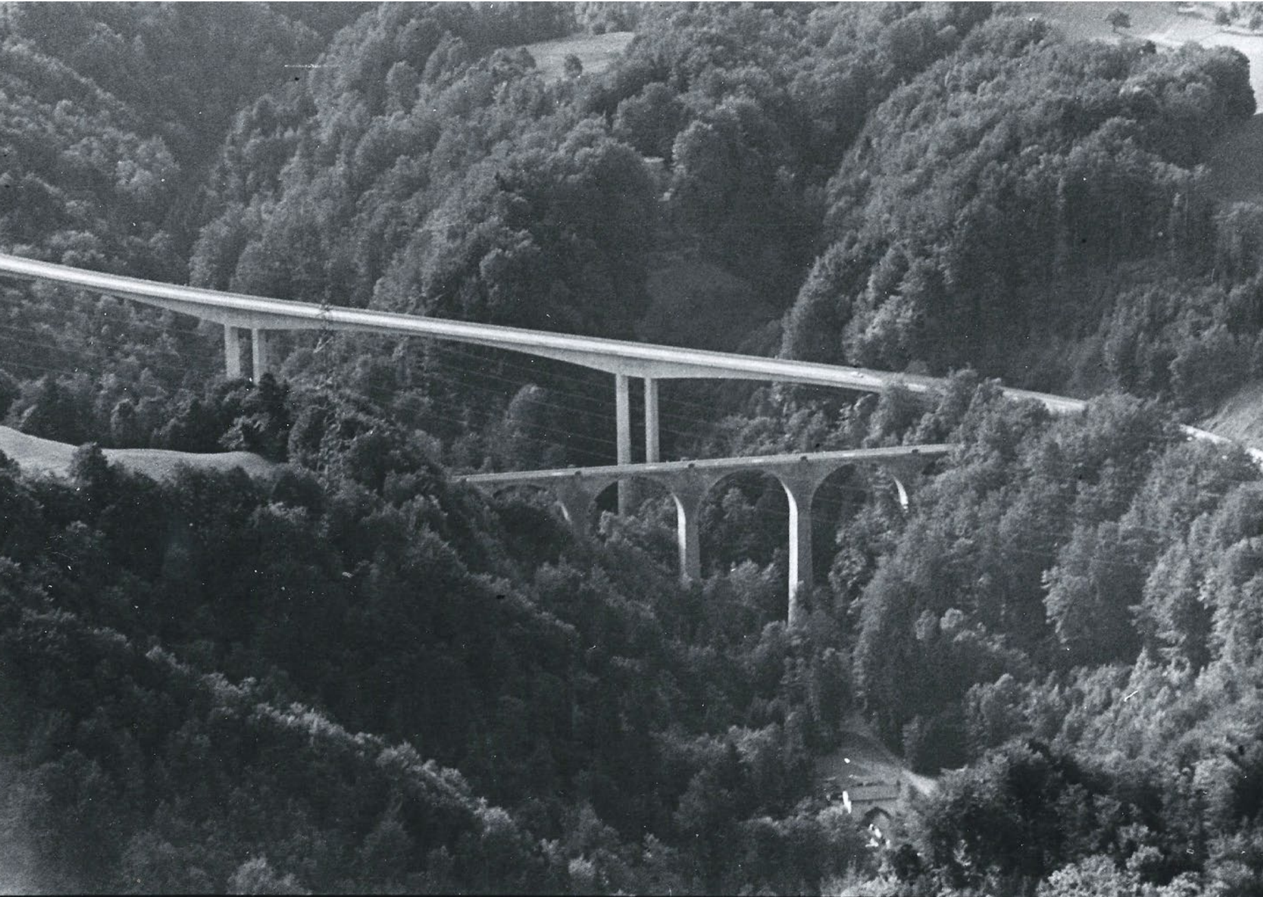
Flugbild nach Eröffnung der neuen Lorzentobelbrücke: Am unteren Bildrand rechts erkennt man die Kraftwerkanlage der Wasserwerke Zug AG. Knapp darüber etwas links, verdeckt durch die Bäume, steht die alte Holzbrücke. Gegen den oberen Bildrand, in der Mitte über dem rechten Doppelpfeiler, erkennt man die restaurierte Wildenburg.
