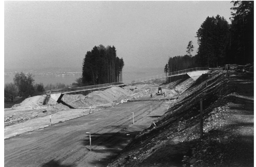
Die fertiggestellte Fussgängerbrücke Birchweid über die noch zu erstellende Autobahn A3. Trasse Blick Richtung Chur vom April 1967.
