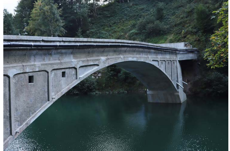
Rückwärtige Ansicht der Schrähbachbrücke mit der für das Erscheinungsbild noch unglücklich aussehenden Wasserleitung an der Brüstung.
