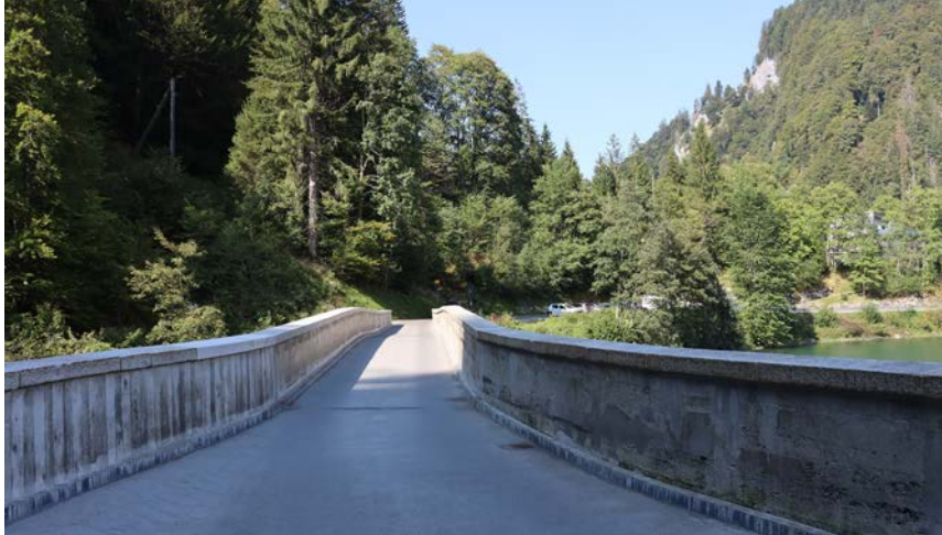
Die Schrähbachbrücke ist nun nach der Instandsetzung voll funktionstauglich und kann sogar mit 40 t-Fahrzeugen befahren werden.
