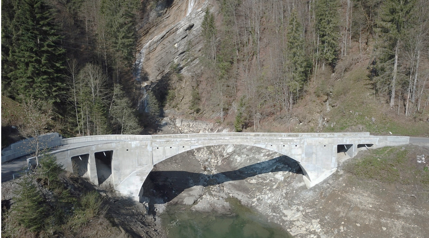
Instandgesetzte Schräbächbrücke fotografiert bei tiefem Wasserstand des Stausees – 27. April 2022.
