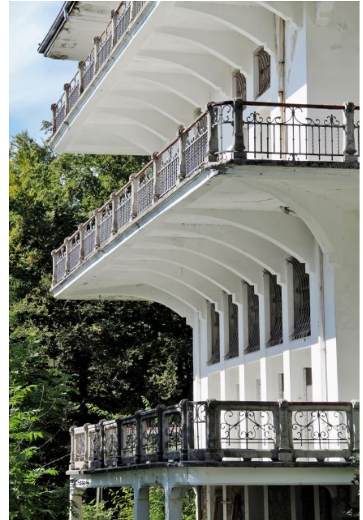
Die Balkone werden von den gevouteten Konsolen getragen. Sie kragen 2.5 m bei den beiden Obergeschossen und sogar 3.3 m im Hochparterre aus.
