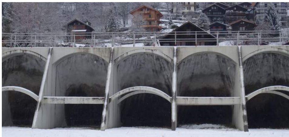
Frontalansicht des Ausgleichsbeckens im November 2017.
