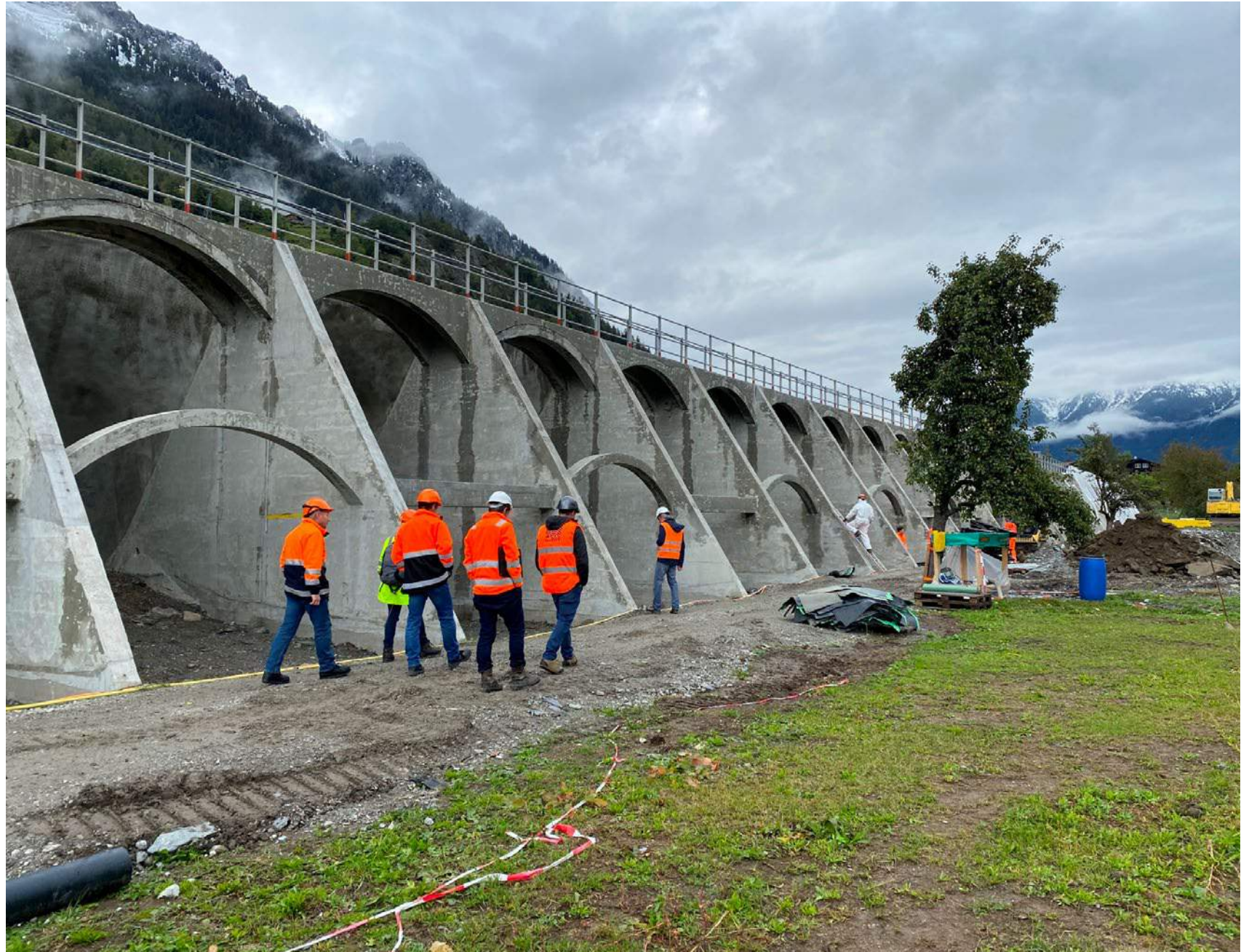
Besuch der Baustelle während der Instandsetzungsarbeiten am 29. September 2020
