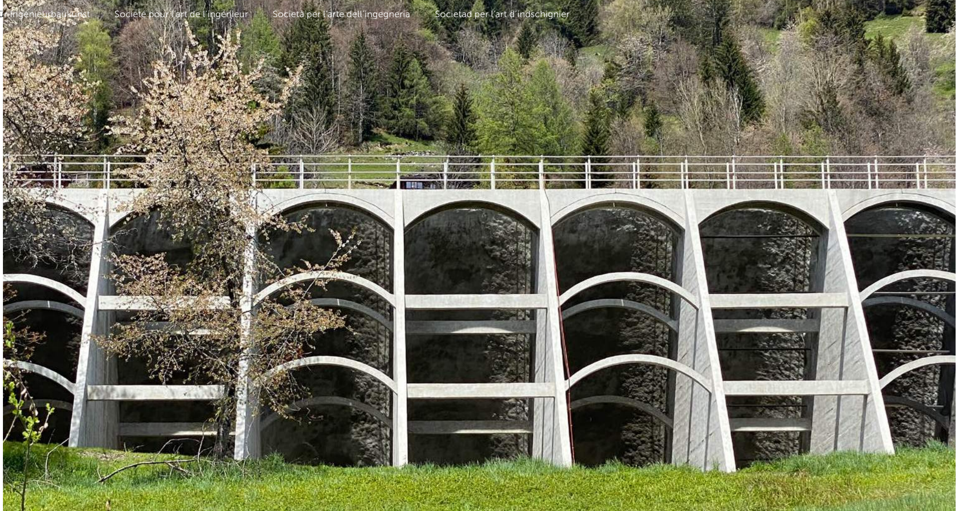
Sichtbeton im Wechselspiel mit der umliegenden Natur: Die filigrane Betonkonstruktion, wie sie heute wieder in nahezu originaler Farbe und Oberflächenbeschaffenheit erscheint; 9. Mai 2021.
