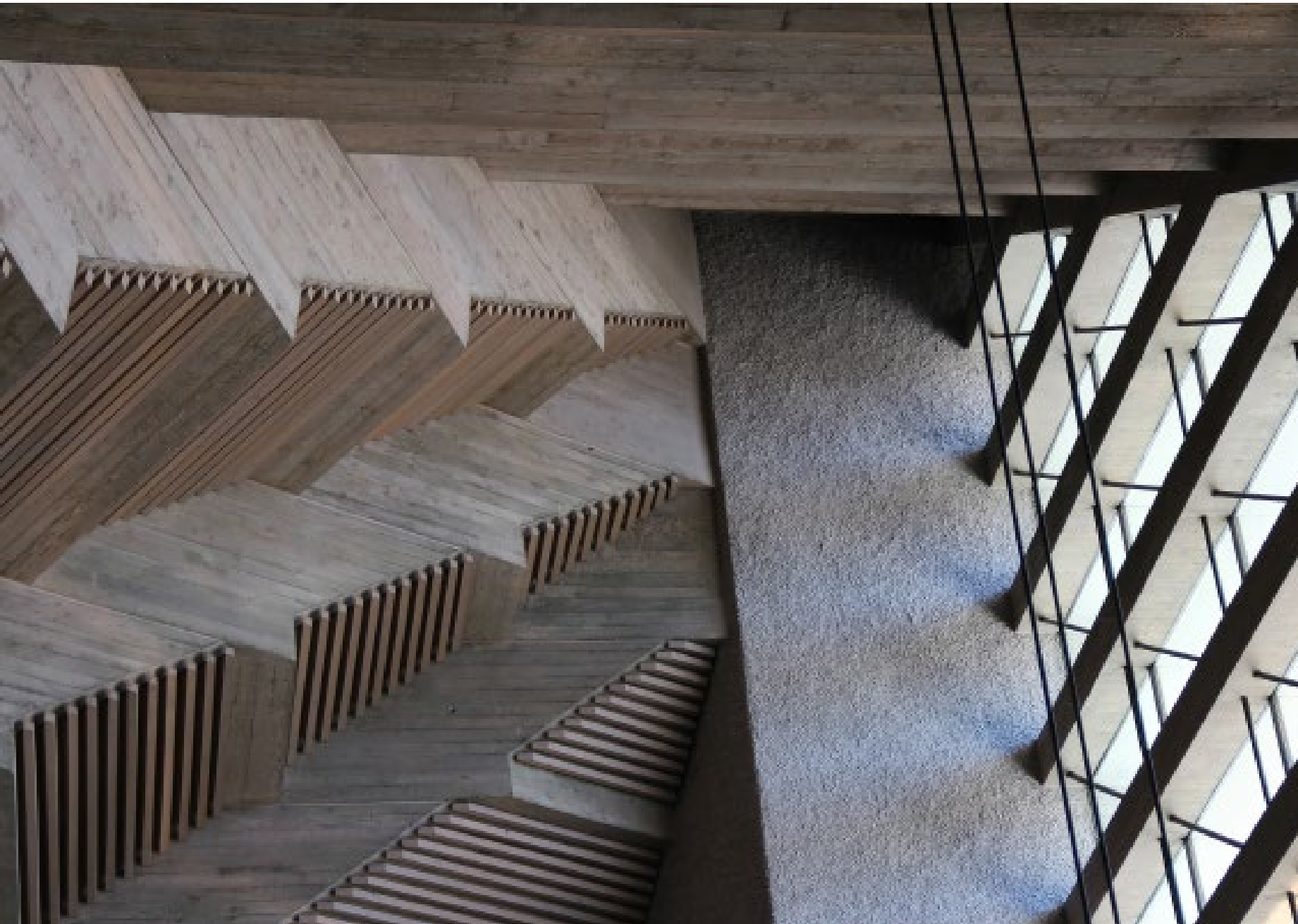
Der Innenraum der Kirche im Wil Dübendorf ist geprägt von einer markanten Betonkonstruktion. Die Flächen, Rippen, Lamellen und Stäbe sind zugleich raumbildend und tragend. Die Spitze des leichten Kirchendachs und die dreiecksförmige Fensterfassade sind an den Turm gehängt.
