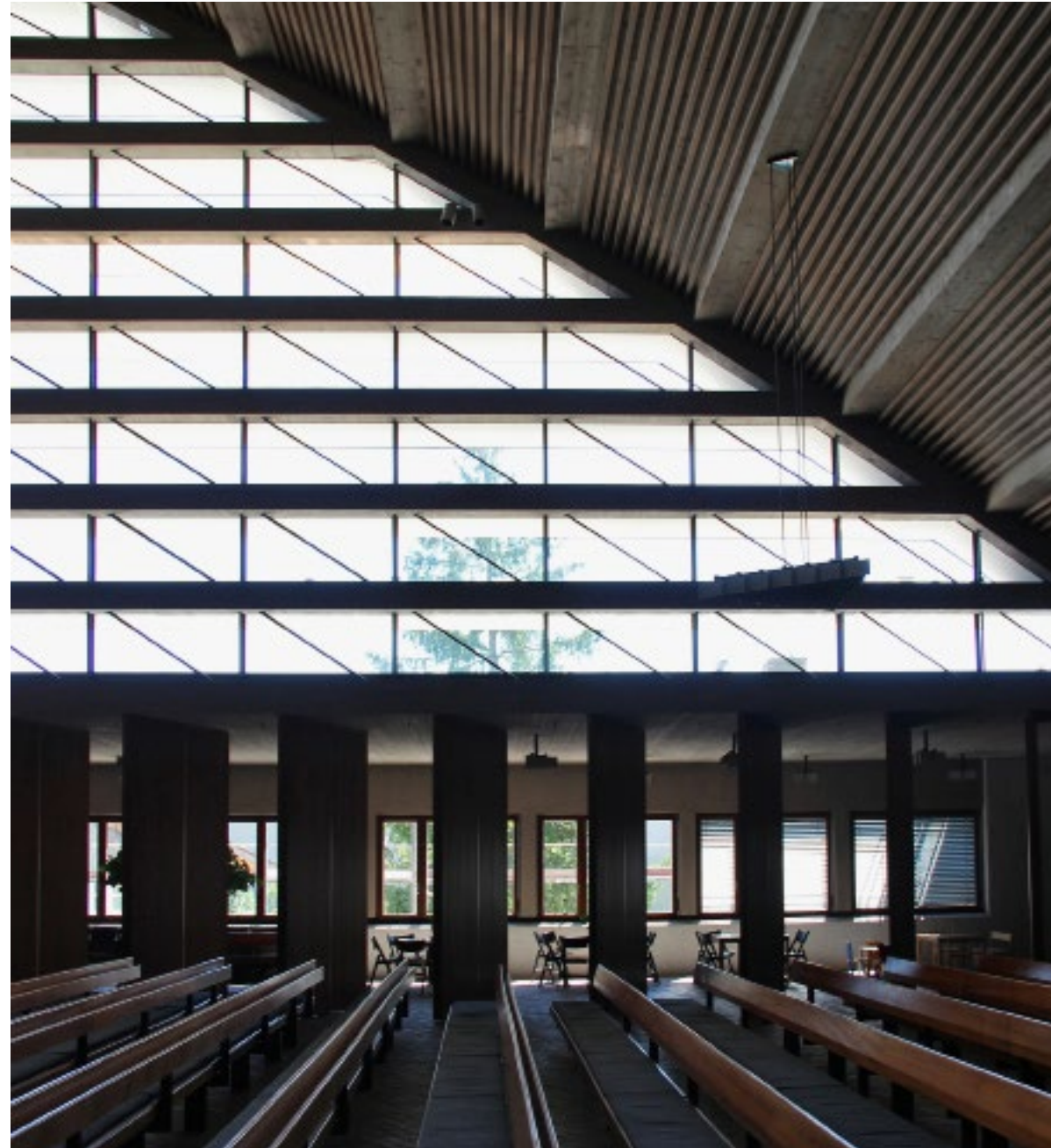
Die feingliedrige Fensterfassade besteht aus dünnen Stahlstäben und schlanken Betonlamellen als Sonnenblenden und schwebt zusammen mit der Foyerdecke frei über dem Kirchenraum.
