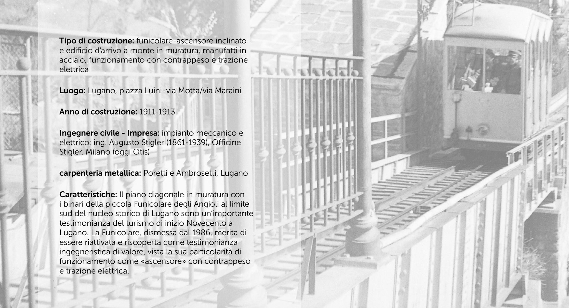
**Tipo di costruzione:** funicolare-ascensore inclinato e edificio d'arrivo a monte in muratura, manufatti in acciaio, funzionamento con contrappeso e trazione elettrica
