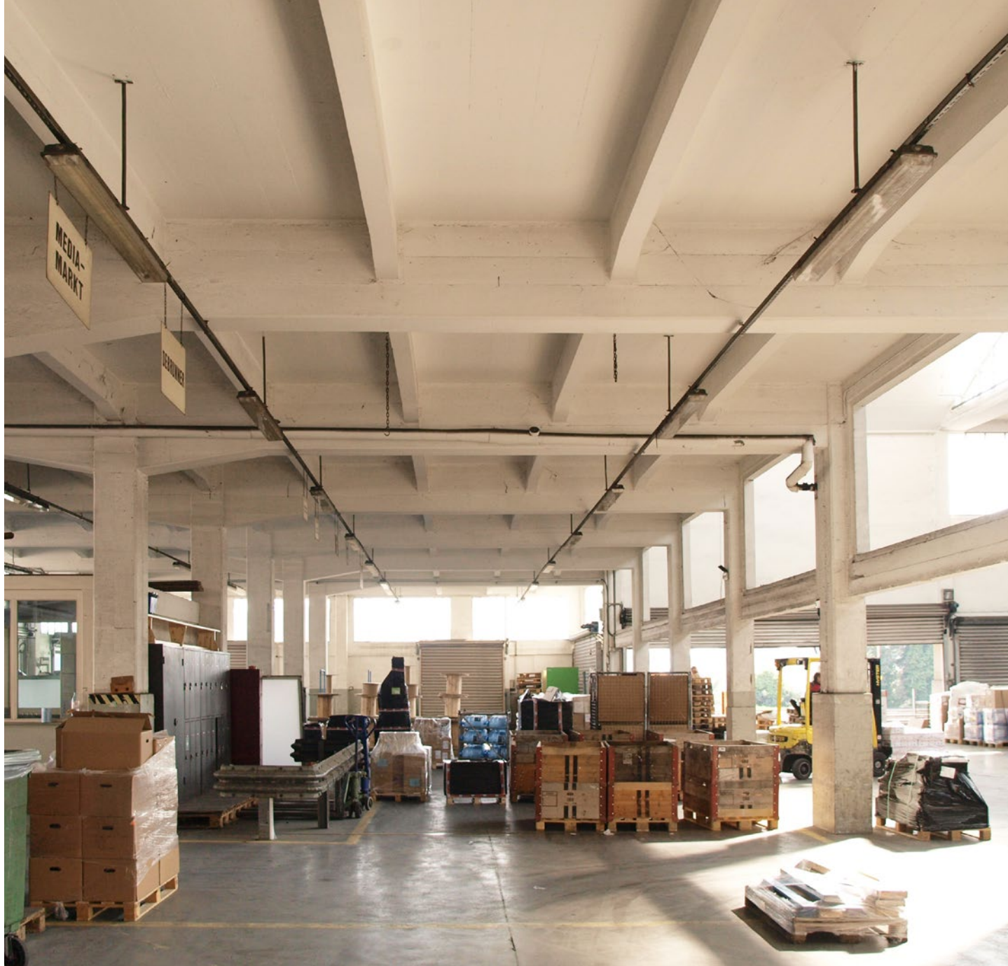
Die Güterhalle besteht im Erd- und im Obergeschoss aus Rippendecken. Im Untergeschoss kamen Pilzdecken zum Einsatz.
