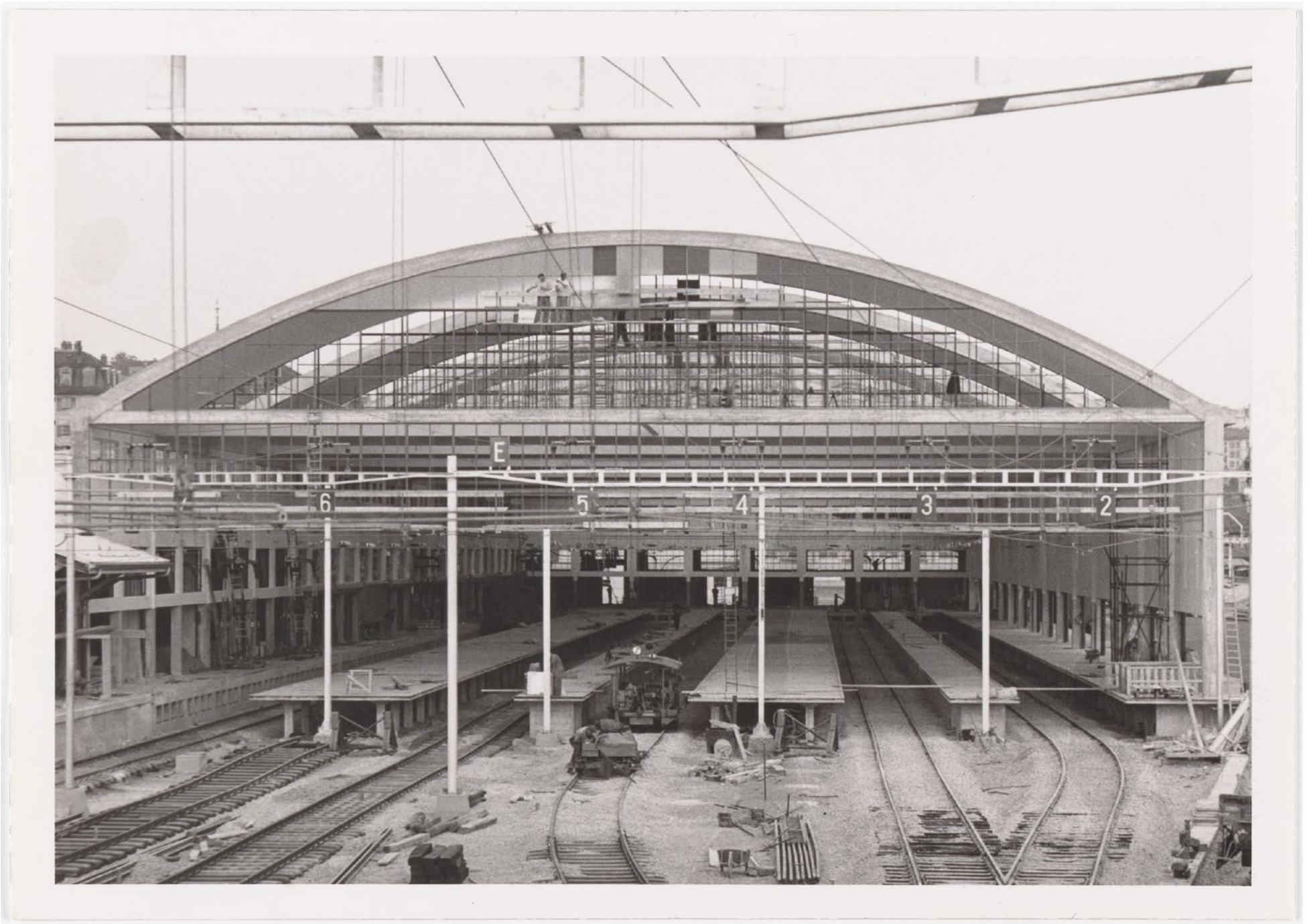
Historische Aufnahme der Baustelle 1951 (BILD: ARCHIV SBB-HISTORIC, FOTOARCHIV)
