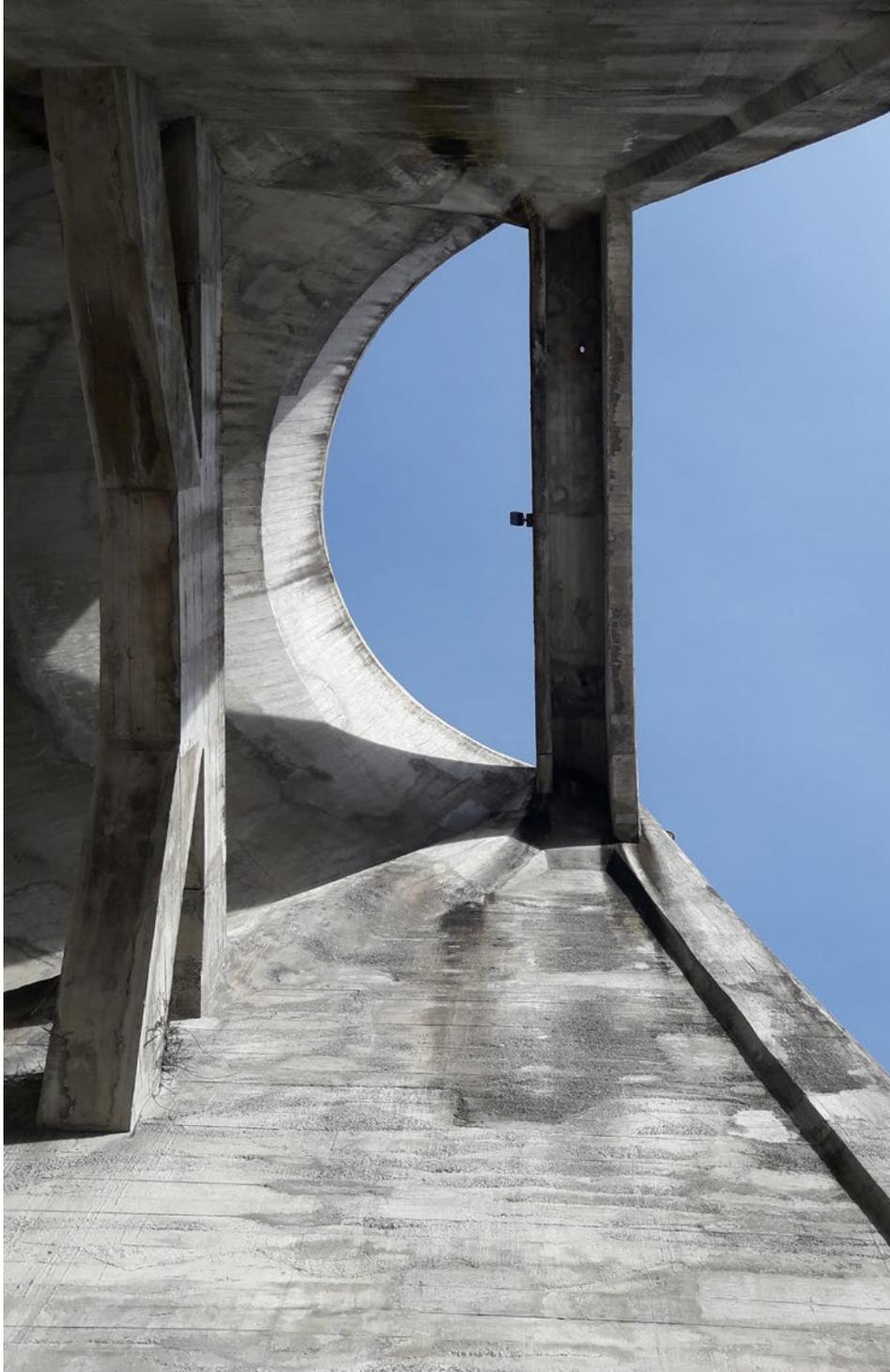
nimmt von oben nach unten linear von 40 auf 60 cm zu, wobei der Radius der Innenseite mit 5.20 m konstant bleibt. Am unteren Ende sind die Gewölbepfeiler in eine etwa 3 m starke Herd- mauer eingespannt, die ihrerseits in den anstehenden Granit einbinden.
