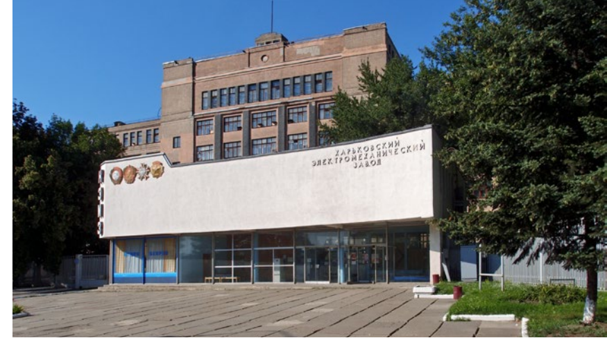
Rundgang um die Elektrogerätefabrik.
