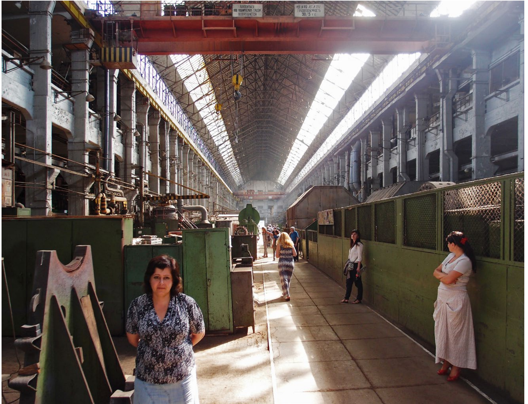
Die Schweizer Ingenieure erbauten das Bauwerk in höchstmöglicher Standardisierung der Einzelheiten. Dieses Prinzip prägt das Tragwerk und gibt den Hallen noch heute ihren Rhythmus.
