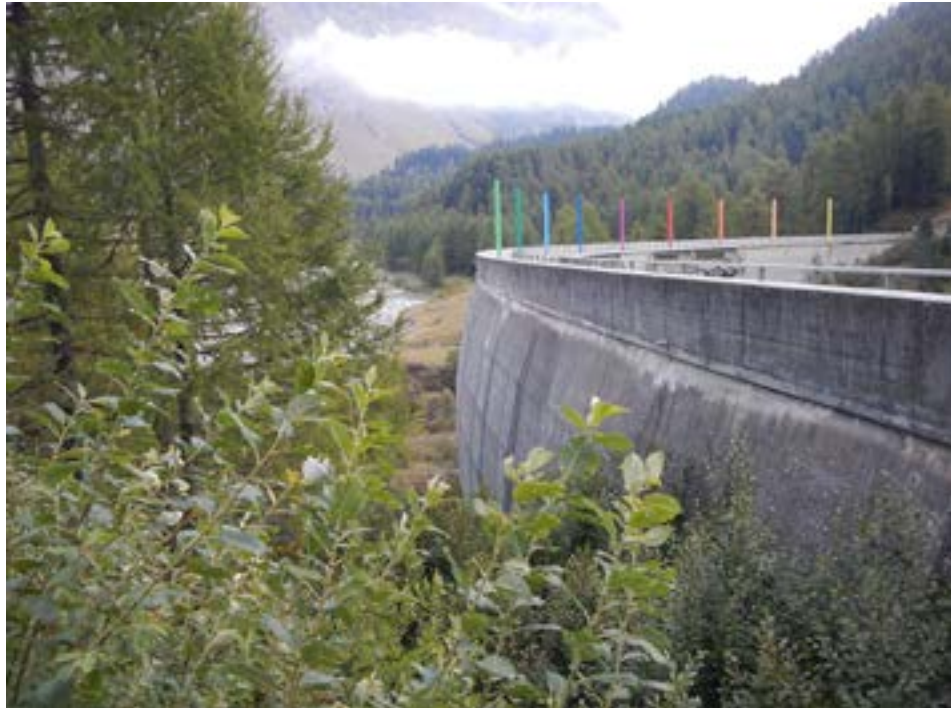
Die Rückhaltemauer inmitten der Vegetation.
