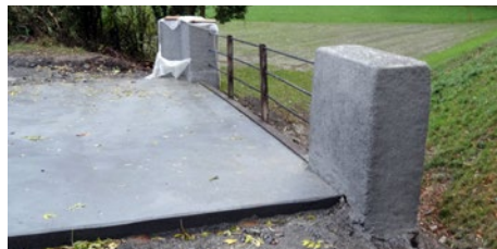
An die randabschliessenden Stahlträger sind die Geländerpfosten befestigt. Um Höhe und Montageweise des Geländers beizubehalten, wurde die Plattenstärke auf die statische Höhe ausgelegt, deshalb sind Platte und Träger nicht bündig.
