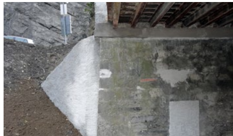
An die randabschliessenden Stahlträger sind die Geländerpfosten befestigt. Um Höhe und Montageweise des Geländers beizubehalten, wurde die Plattenstärke auf die statische Höhe ausgelegt, deshalb sind Platte und Träger nicht bündig.
