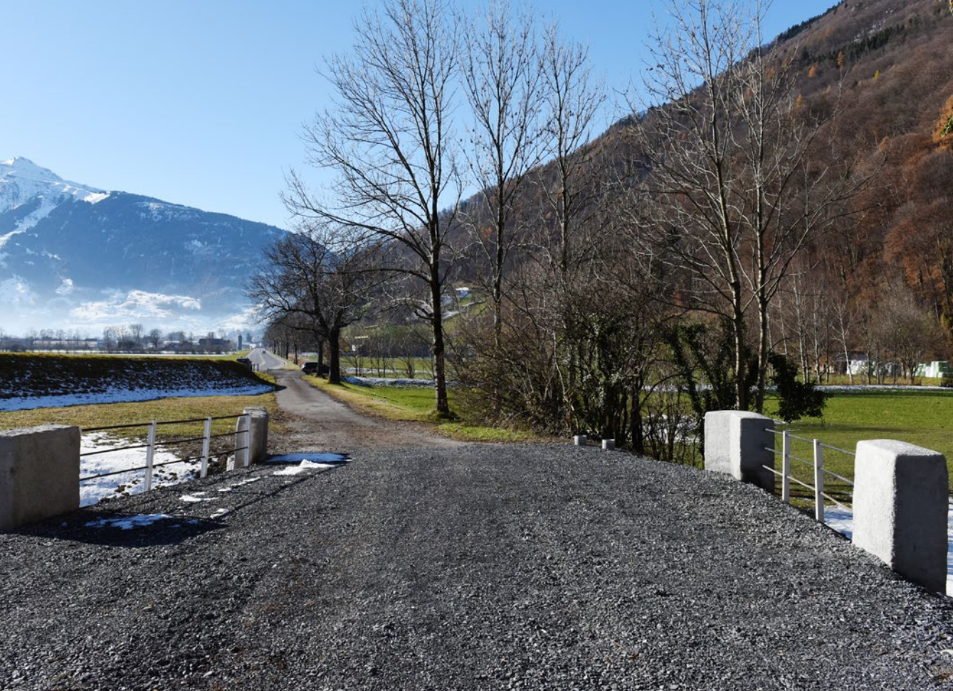
Blick nach Südwesten über die Fahrbahn der ungewöhnlich breiten Brücke in die Längsachse des Strassendamms von 1822 durch die Saarebene.
