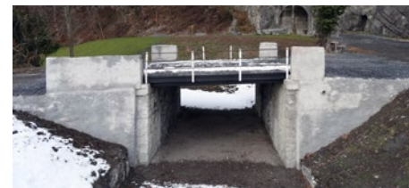
Die aus Bruchsteinen aufgemauerten, verputzten und mit Decksteinen abgeschlossenen Postamente sind wie die Widerlagermauern aus dem 19. Jhd. Das Geländer mit vier Pfosten und drei massiven Eisenholmen entspricht wie die Fahrbahnkonstruktion dem Zustand von 1893.
