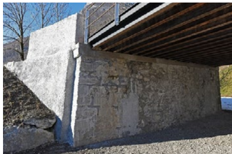
Die aus der Flucht der nur wenig ausgestellten Flügelmauern zurückspringenden Widerlagermauern sind ein typisches Gliederungselement des 19. Jhd. Sandsteinplatten bilden den oberen Abschluss. Sie wurden wohl beim Umbau 1893 angepasst an die Stahlträger mit einem bandförmigen Zementputzgesims verkleidet.
