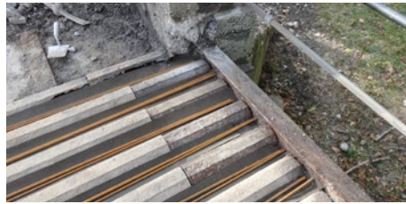
Verrostete Zoreisen wurden mit neuen, aus dem Lager des Bauunternehmens ergänzt. Zwischen den Zoreisen wurden Dachpappenstreifen als verlorene Schalung eingelegt und mit Bewehrungsseisen ausgelegt.
