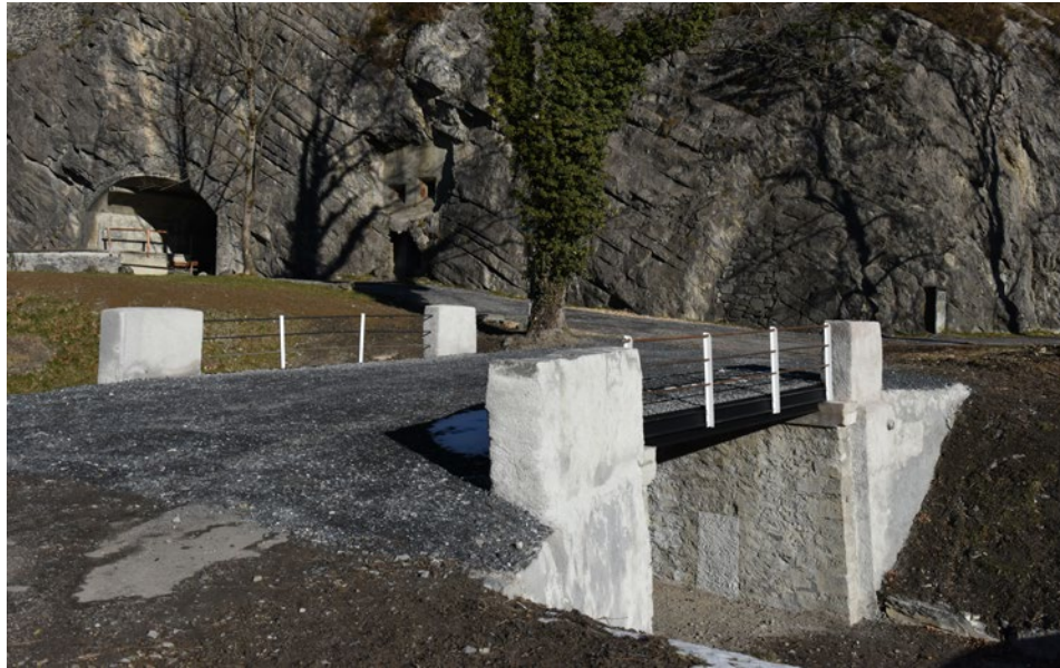
Ansicht der Schlichergrabenbrücke nach Abschluss der Restaurierung. Blickrichtung Nord, im Hintergrund die Hohwand des Schollbergs mit den Eingängen der Festung Schollberg 3.
