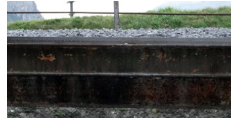
Damit Höhe und Randstabilität der Schotterdecke erreicht werden, ist nach altem Vorbild auf der Betondecke ein Winkeleisen montiert.
