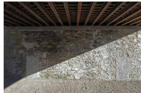
Ansicht der nordöstlichen Widerlagermauer mit den beiden verputzten Sprengkammern: Diese waren mit Kalksandsteinen ausgemauert worden, die anscheinend bereits einmal verputzt waren, aber durch Verwitterung Schaden genommen haben. Sie wurden verputzt, um die Verwitterung zu stoppen.
