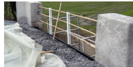
Die Randträger erhielten einen schwarzen Schutz- und die Geländerpfosten einen weissen Warnanstrich. Der bituminöse Anstrich der nun dichten und belüfteten Brückenunterseite blieb, da jetzt geschützt und die Kosten für eine Erneuerung unverhältnismässig gewesen wären.
