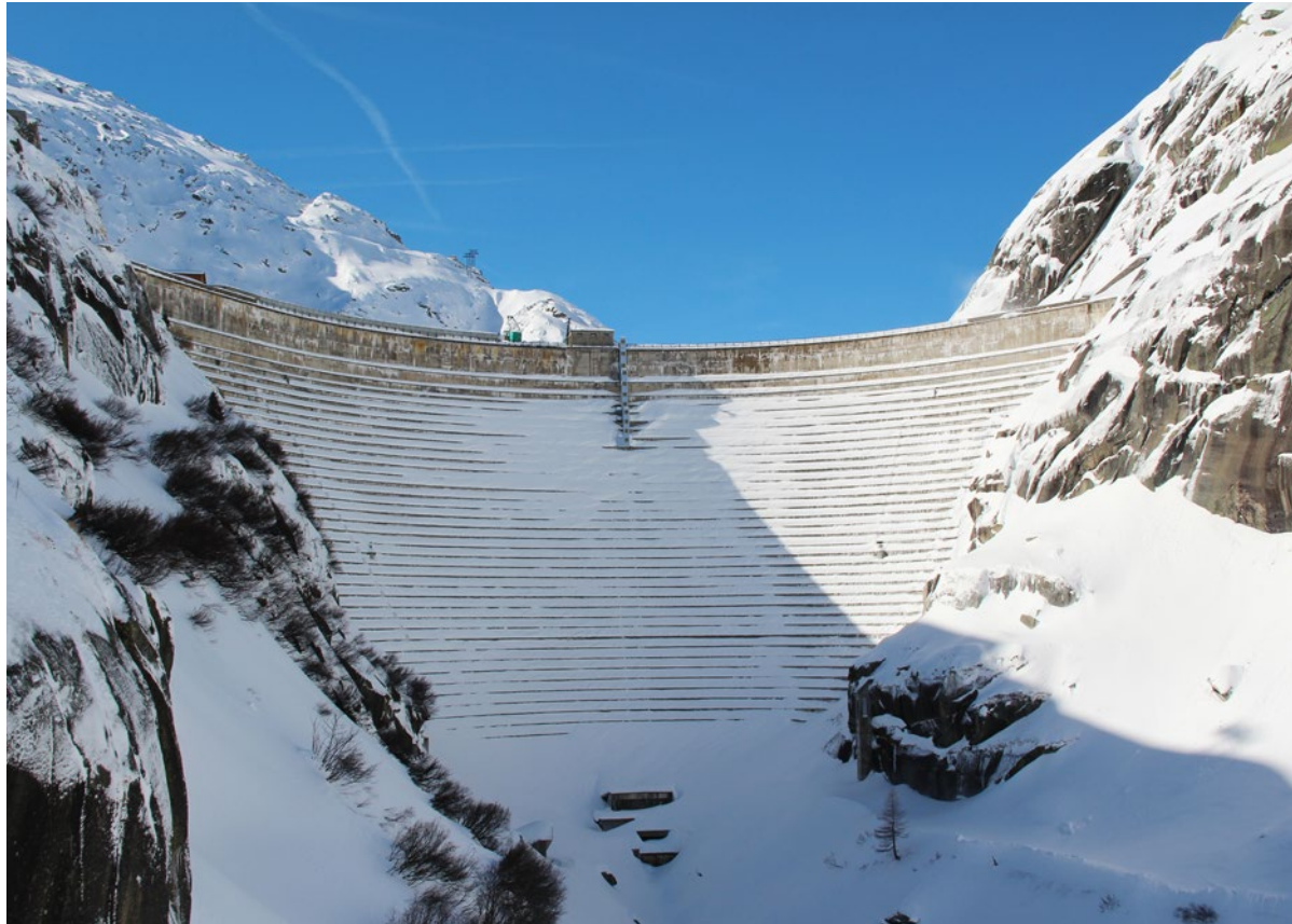
Die kombinierte Bogen- und Gewichtsstauer mit ihrer typisch abgestuften Talansicht.
