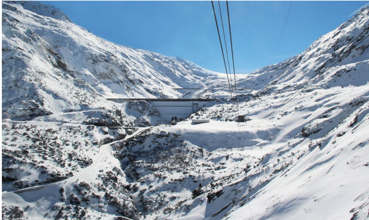
An der Grimsel entstand seit der Gründung der KWO 1925 ein komplexes Kraftwerkssystem mit elf Kraftwerken und acht Speicherseen. Pro Jahr produziert die KWO rund 2350 Gigawatt-Stunden elektrischen Strom, was etwa 7% der Produktion aller Schweizer Wasserkraftwerke entspricht. Diese Energie deckt den Jahresverbrauch von rund einer Million Menschen.
