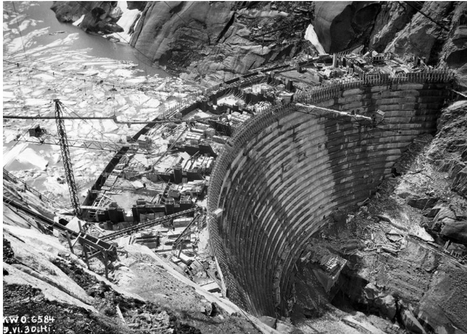
Hauptstaumauer Spitalamm während der Bauausführung im Juni 1930 (oben: Blick vom Nollen; rechts: Blick zum Nollen mit dem neuen Hospiz. Der Beton für die Talsperre wurde teils mit Giessrinnen, teils mit Kabelkranen eingebracht.
