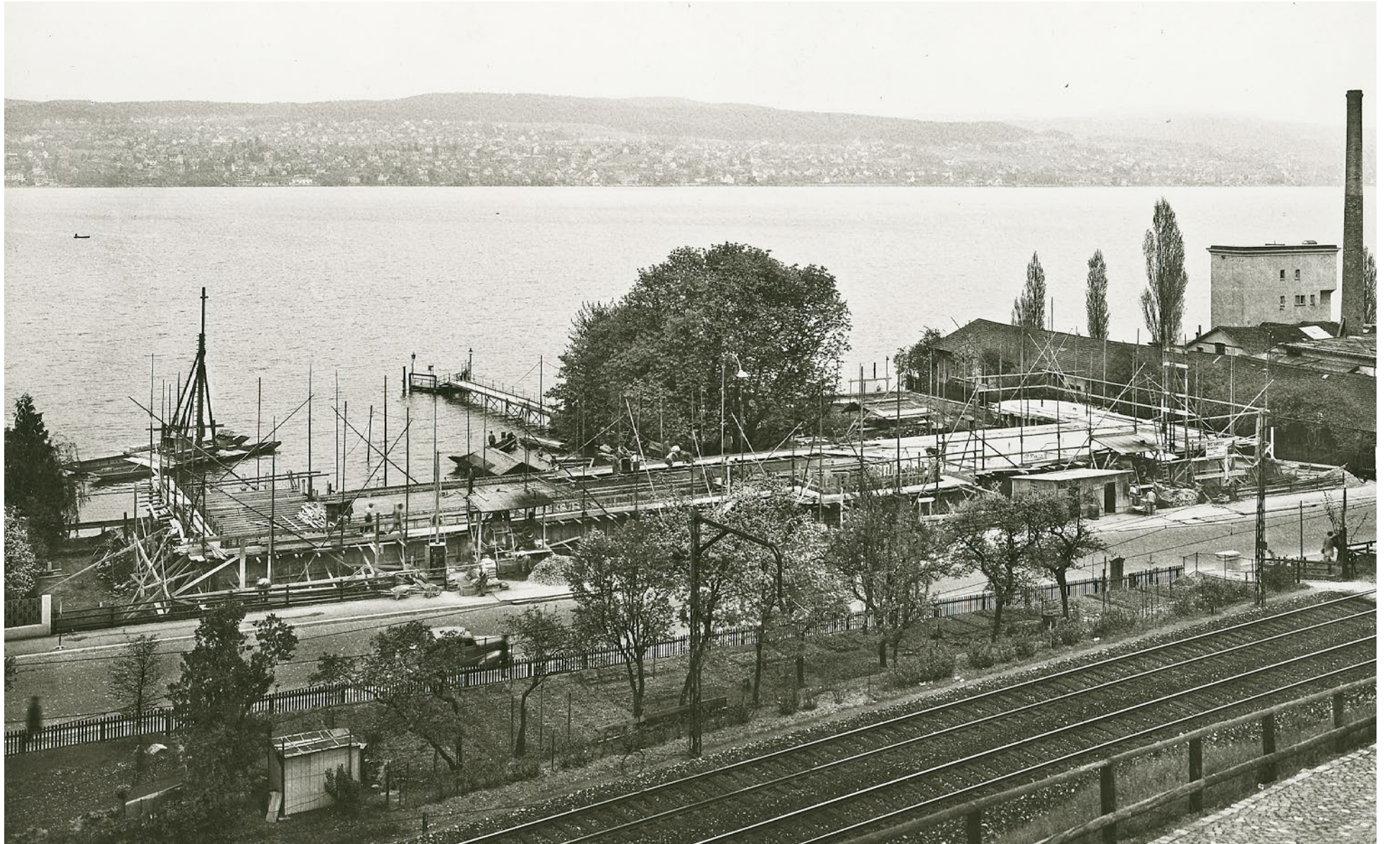
Baustellenbild aus dem Jahr 1939. Alle Mauern mussten auf Holzpfählen in der Seekreide fundiert werden; bei den Schwimmbecken wurde die Seekreide ausgebagert und durch Kies und Sand ersetzt.
