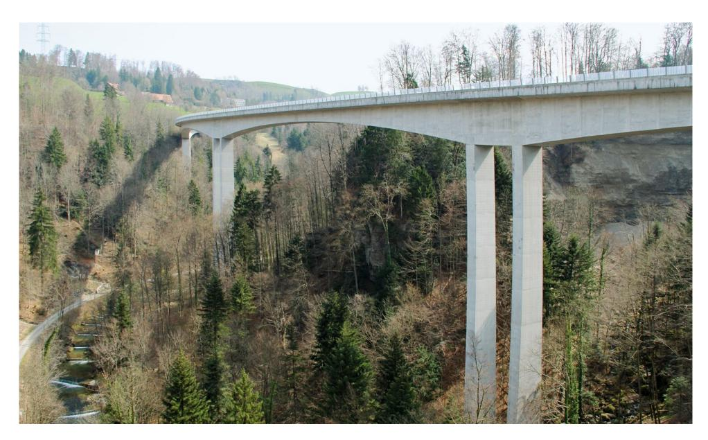
Die jüngste Lorzentobelbrücke prägt die Landschaft mit kühnen Akzenten der Ingenieurbaukunst. Sie steht auf Doppelstützen und spannt als Spannbetonbrücke in einem leichten S über das tiefe, bewaldete Lorzentobel. Fundament, Doppelpfeiler und Überbau bilden ein homogenes räumliches Rahmentragwerk.
