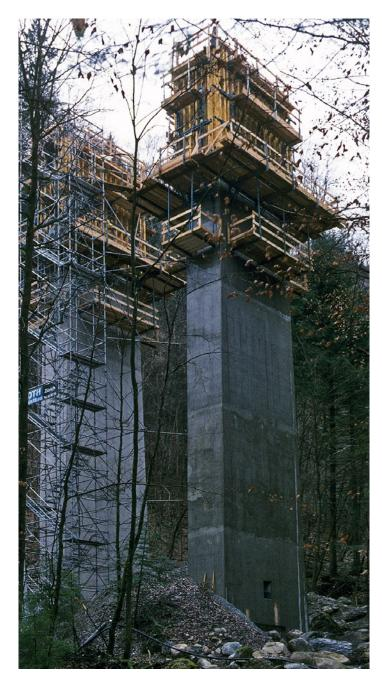
Klettergerüst am Doppelpfeiler (links) und Freivorbaugerüst am Mittelpfeiler (rechts).
