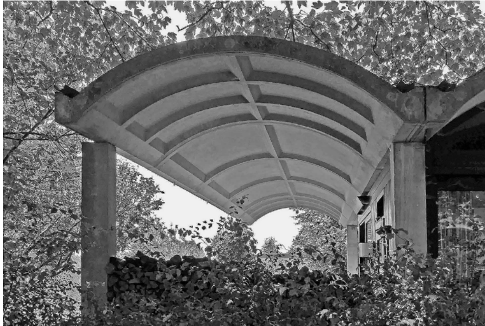
Das Bauernhaus in Hittenkirchen erhält seine untypische Form durch seine Kreissegmentshalen. Finsterwalder entwarf sie, um ein neues Vorbild für die Landwirtschaft zu schaffen.
